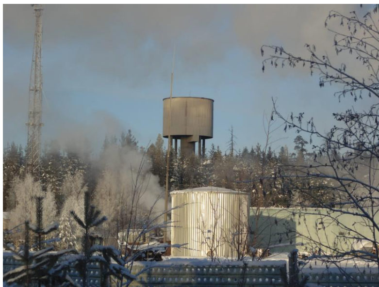
Рисунок 9. Резервуары с песком.
