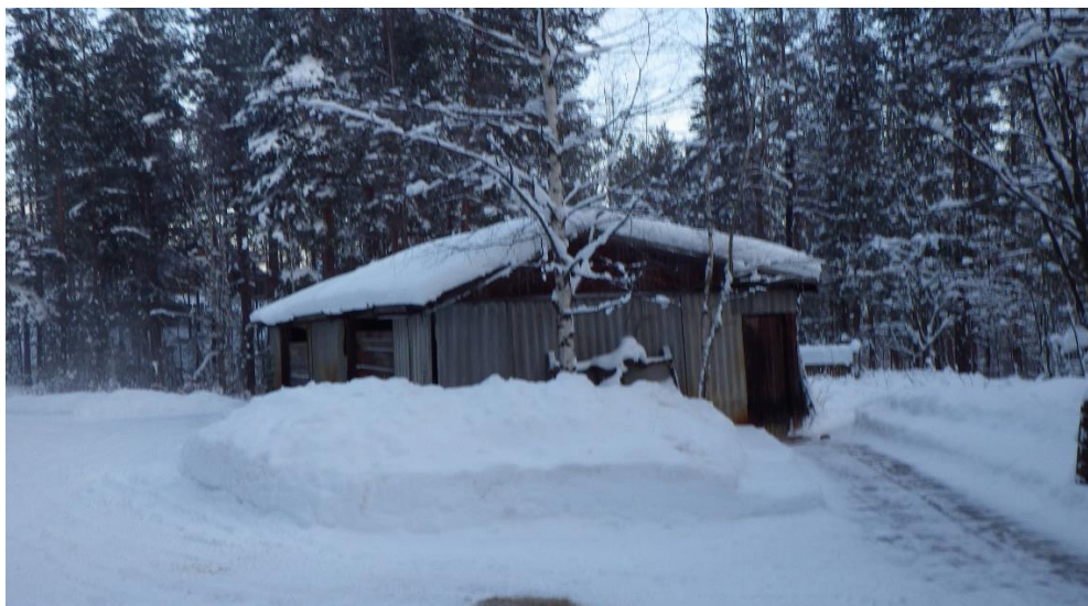
Рисунок 12. Канализационное очистное сооружение (КОС)
