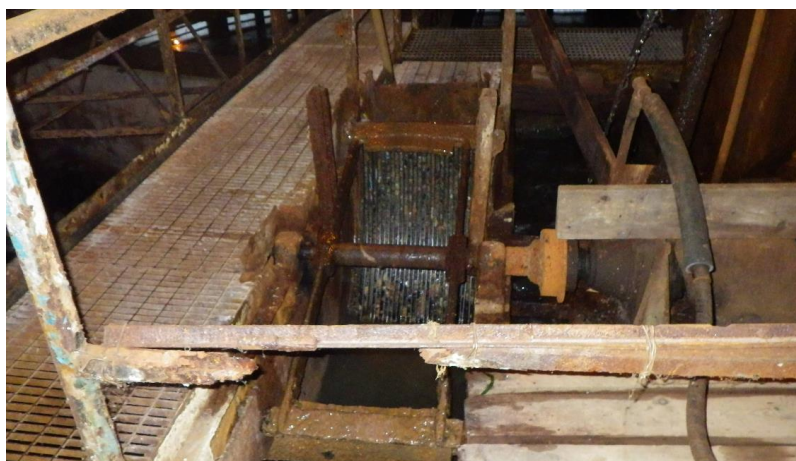
Рисунок 14. Механическая решётка-улавливатель твердых отходов
